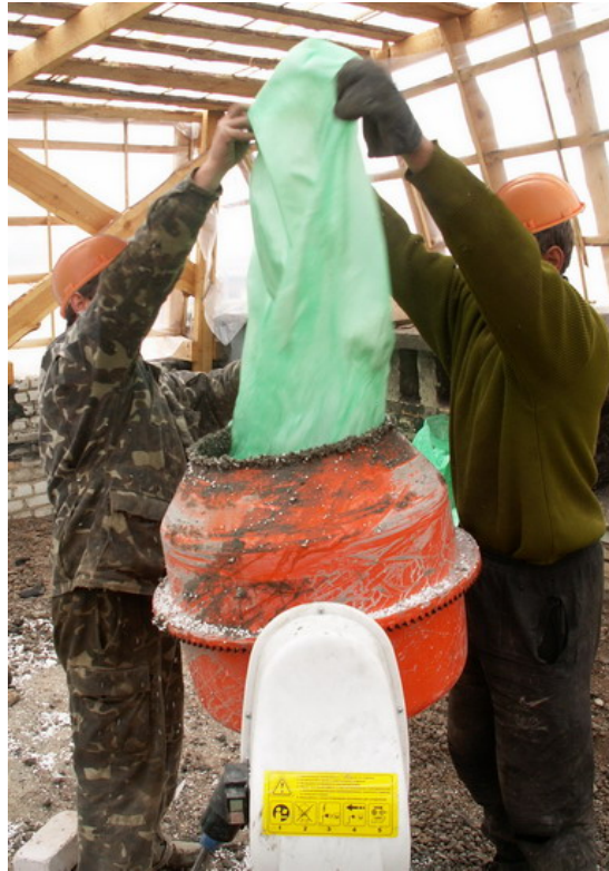
Рисунок 11 – Засыпка в растворомешалку пенополистирольной крошки (компонент Б)
