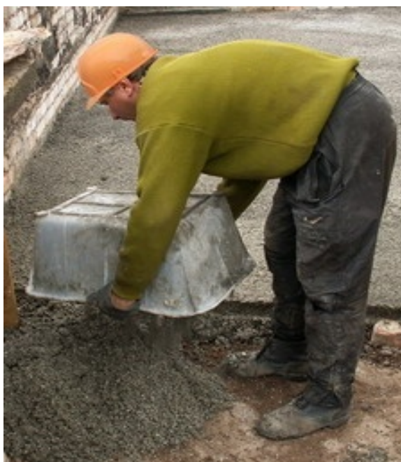
Рисунок 13 – Укладка готовой смеси
