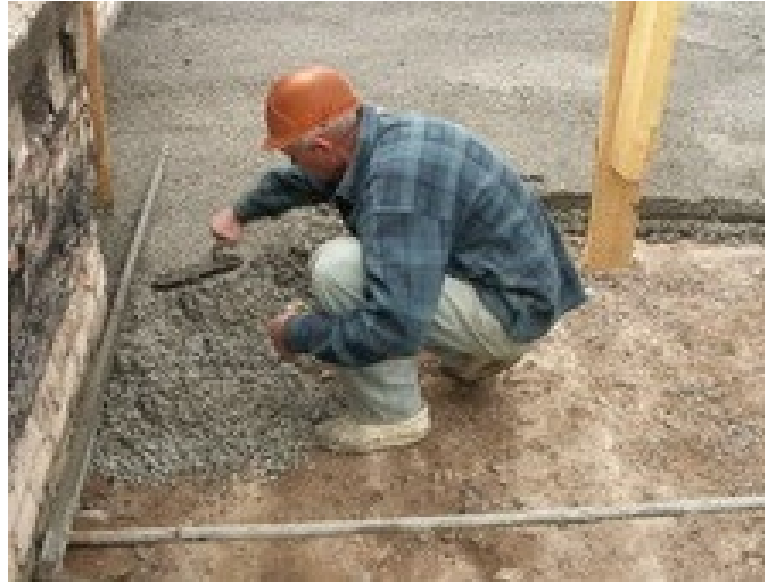
Рисунок 14 – Разравнивание и заглаживание уложенной смеси
