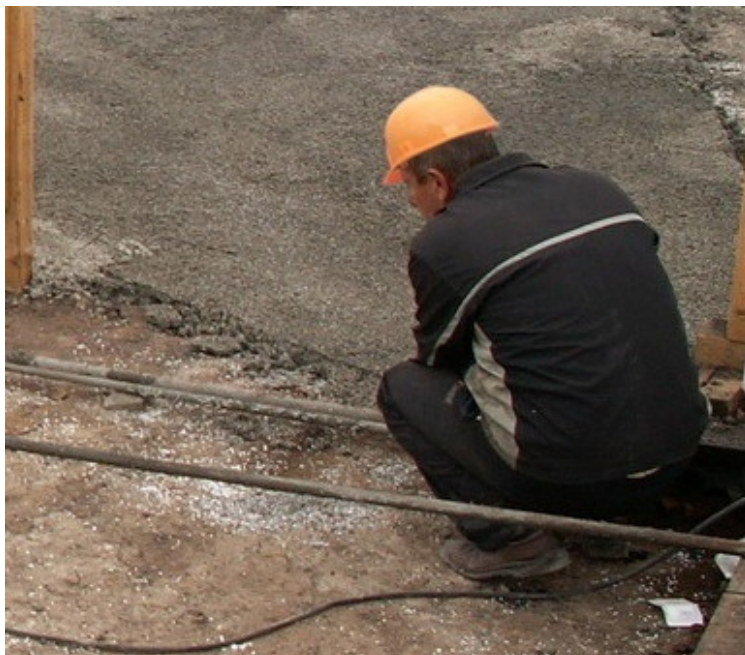
Рисунок 12 – Установка маячных реек
