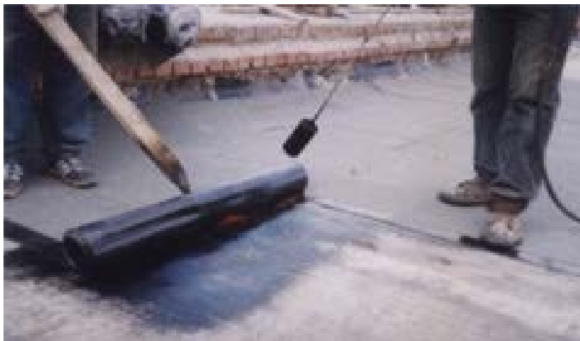
Рисунок 16 – Приклеивание напусков рулонного слоя «Термоплита»
